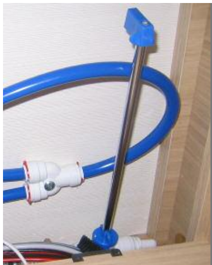
VANNE DÉCHARGEMENT COMPLET RÉSERVOIR
