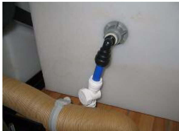
VANNE DÉCHARGEMENT PARTIEL RÉSER- VOIR
